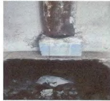
Foto 16: Sustrucción de chimenea de metal
