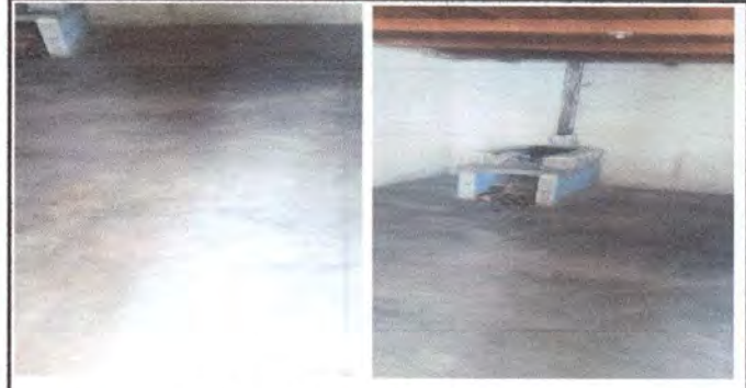
Foto 8: Sustitución de piso de la cocina
