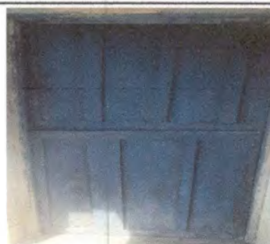
Foto 4: Sustitución de puerta de madera por metal
