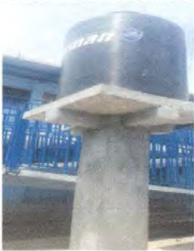
Foto 13: Sustrucción de un deposito de agua de 1,100 litros con sus accesorio
