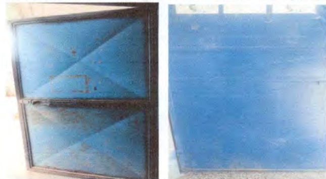
Foto 2: Mantenimiento de pintura a puertas del modulo uno y dos
