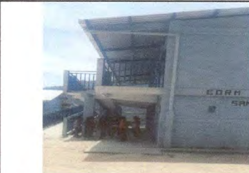
Foto 9: Reparación de bajadas de agua pluvial, tubo PVC 3 pulgadas
