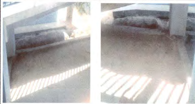
Foto 7: Sustitución de plancha de concreto bajo la rampa y evitar propagación de mosquitos en tiempo de lluvia
