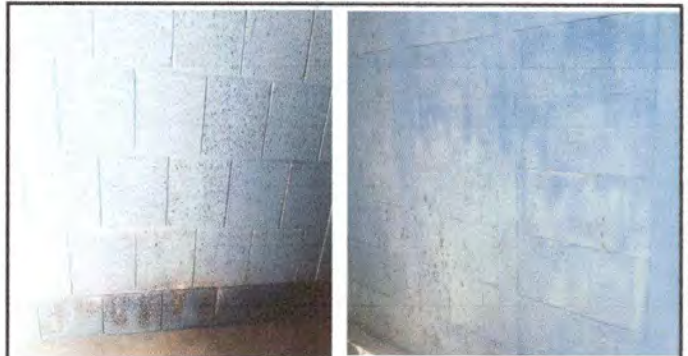
Foto 10: Cambio de pintura de las cuatro aulas del modulo 1
