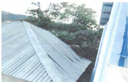
Foto1: Cambio de lamina y costaneras de madera por metal de la cocina
