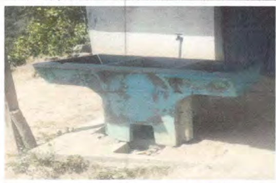
Foto 14: Sustrucción de pila de cemento de dos alas (tanque)
